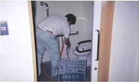
介護施設トイレ
